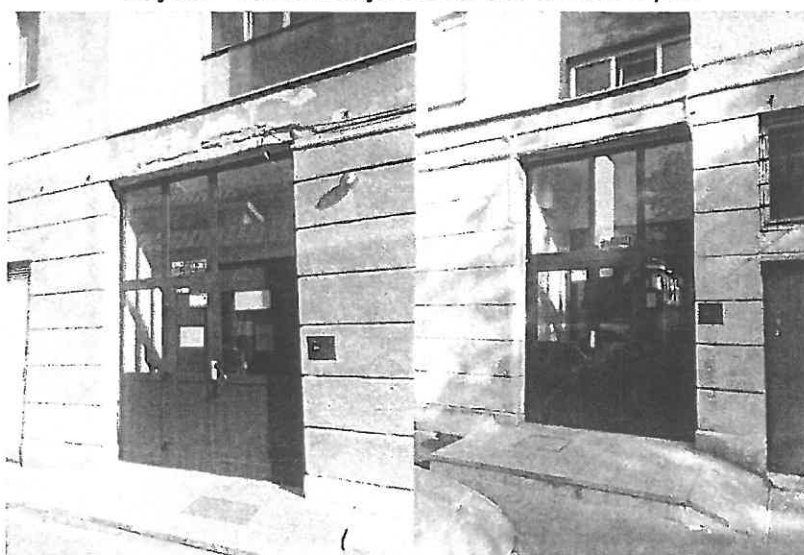
Zdj.03 – Opracowywane otwory drzwiowe
